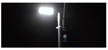
暗い夜道を照らす防犯灯の管理など
