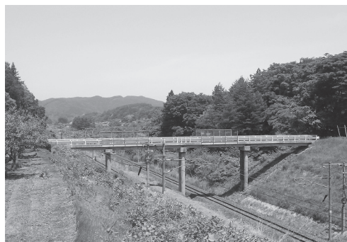
留ヶ崎2号橋（写真）の補修工事や橋梁点検を行います。
