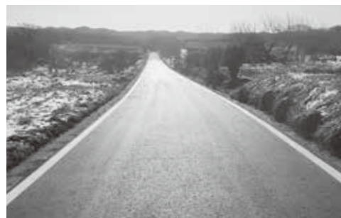
道路改良舗装工事を行いました。 (写真：上目時1号線)
