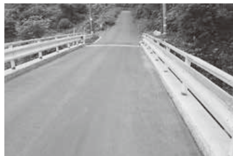
老朽化した橋梁の補修工事を行いました。 (写真：大谷地橋)
