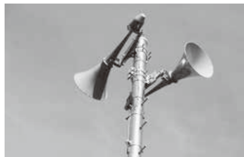
既設のアナログ設備を 全面改修により一新します。
