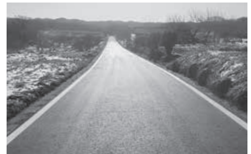
道路改良舗装工事を行いました。 (写真：上目時1号線)
