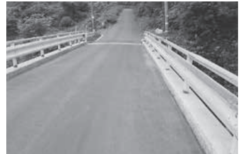
老朽化した橋梁の補修工事を行いました。 (写真：大谷地橋)
