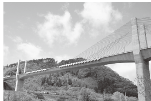
橋梁の長寿命化を図るため、補修工事や定期点検を実施
