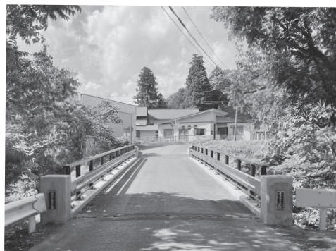
杉東橋（写真）の補修工事などを行い、橋梁の長寿命化を図りました。
