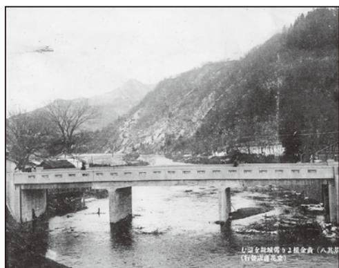
▲鉄筋コンクリート造 昭和7年に落成した 鉄筋コンクリート造 の黄金橋。
