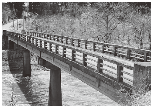
遠小橋をはじめとする橋の補修工事を実施
