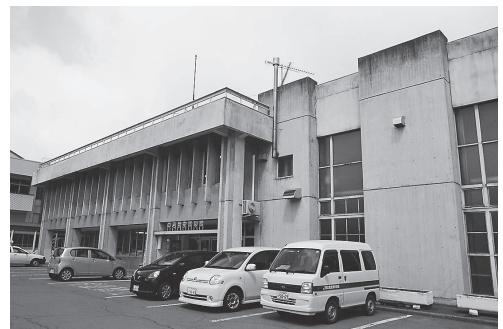
中央公民館の外壁等の補修工事を行い、 より利用しやすい場所となるように
