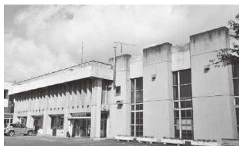
外壁などを補修した中央公民館
