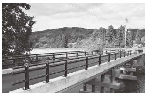
橋梁長寿命化を図り補修された武士沢橋
