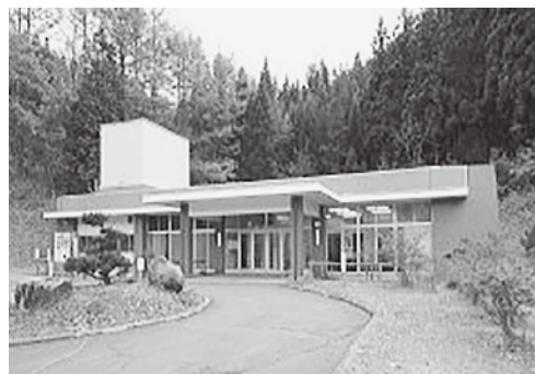
古い葬祭場を取り壊し、新しい葬祭場に建て直します。
