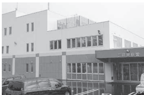
旧町民グラウンドに完成した三戸警察署
