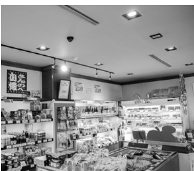
老朽化した空調設備を更新する道の駅
