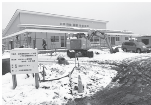
認定こども園の開園に向け工事をしていたいずみ幼稚園
