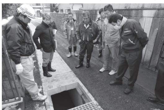
側溝改良工事の調査 (菖蒲沢線)
