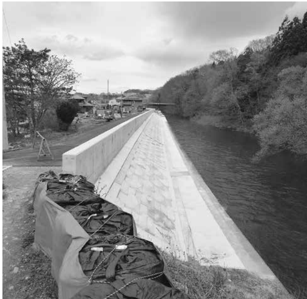
堤防を設置した橋ノ下地区
