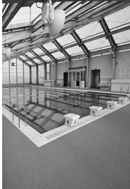
完成した町民プール
