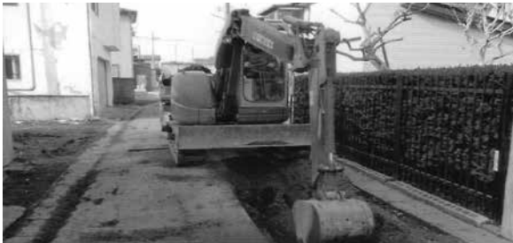
下水道工事のようす
