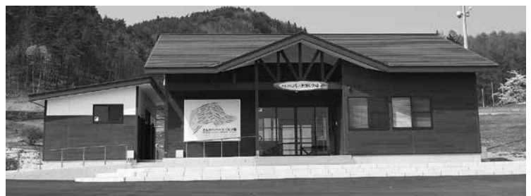
パークゴルフ場管理棟
