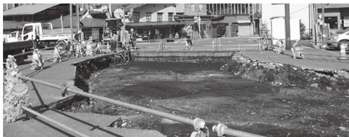
道路整備工事のようす
