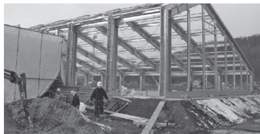
建設工事中の町民プール
