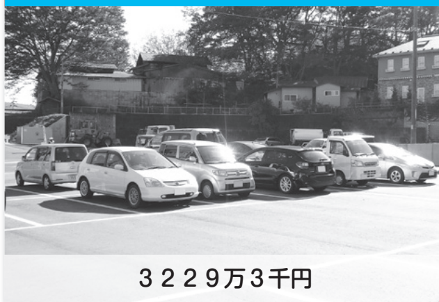
役場駐車場拡張工事
