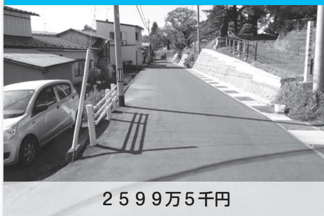
黄金橋公民館線道路工事
