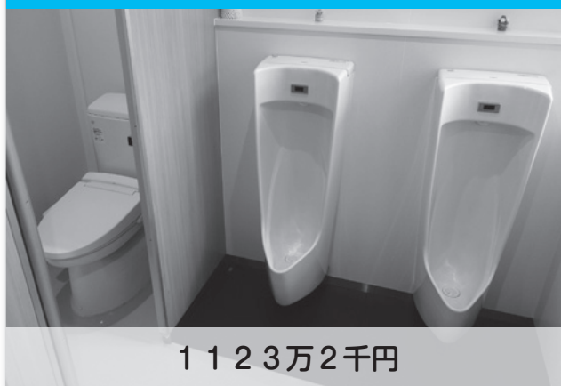
公民館トイレ改修
