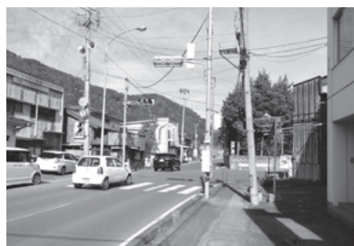
町道府金線と県道の交差点
