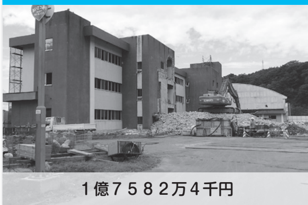
旧三戸中学校解体工事
