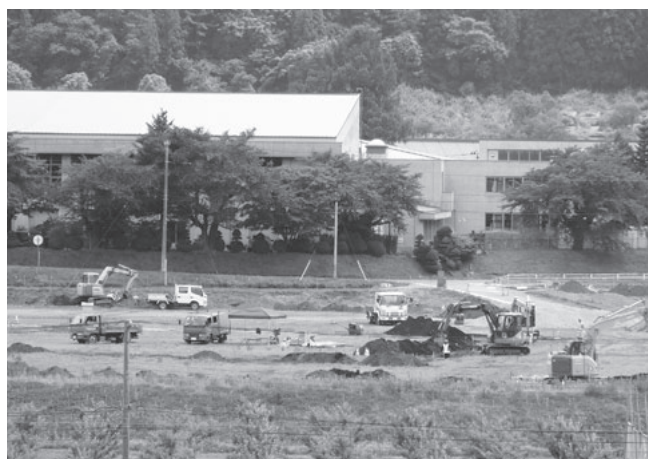
運動場整備が進行中
