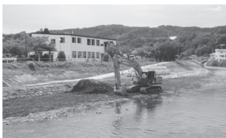
関根川原地区の河川改修
