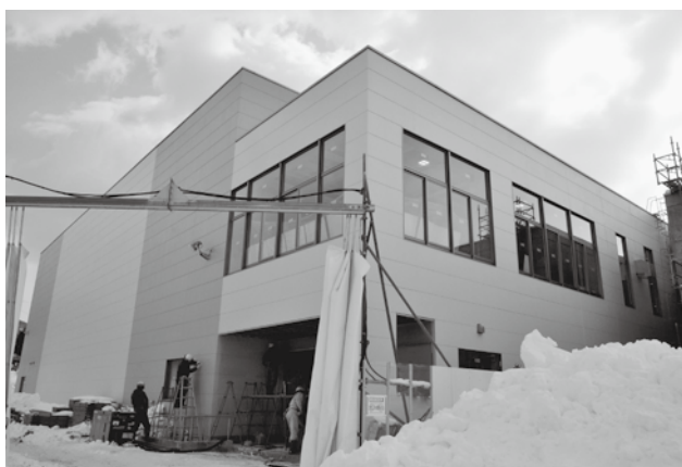
写真2 体育館外観工事のようす(2月19日時点)
