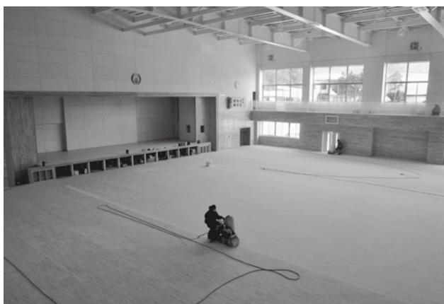
写真1 体育館全景(2月19日時点)
