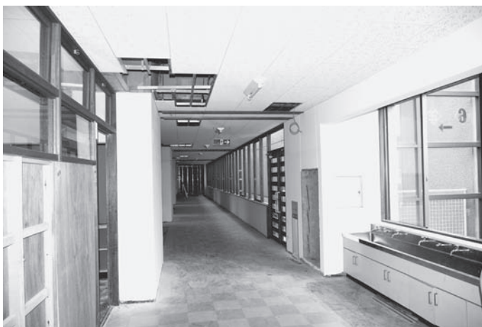
写真3 改造（壁塗り直し、床面補修、収納棚更新など）中の旧校舎
