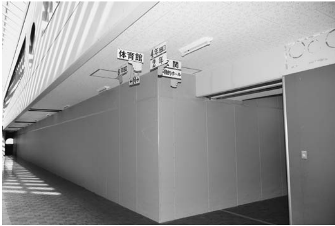
写真4 仮設の壁で生活空間と区分
