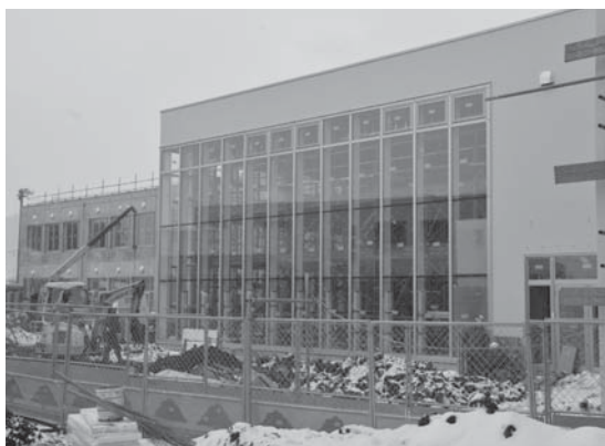
北側からの外観
