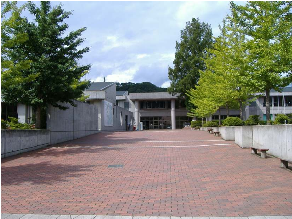
写真：正門側から昇降口を見る
