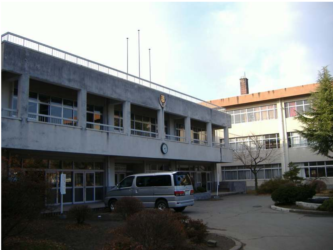
写真：正門側から校舎を見る
