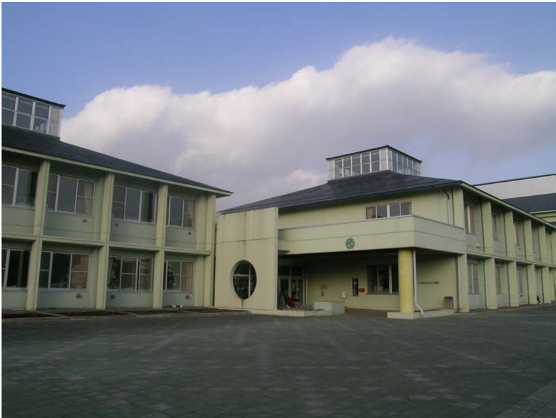
写真：正門側から校舎を見る
