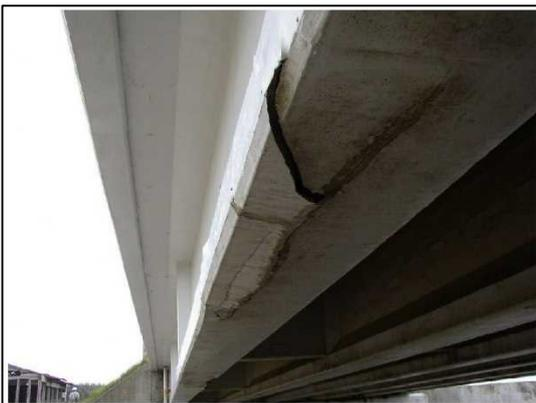
**塩害：**海からの飛来塩分で、コンクリート構造物内部のPCケーブルが腐食し、膨張したことによる、主桁下面への大きなひび割れが確認される。
