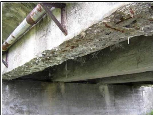
**凍害：**冬期間の凍結融解作用で、主桁下面のかぶりコンクリートがはく離し、一部鉄筋が露出しているのが確認される。
